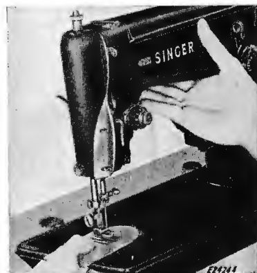
Fig. 33 - Per sostituire le placca d'ago
